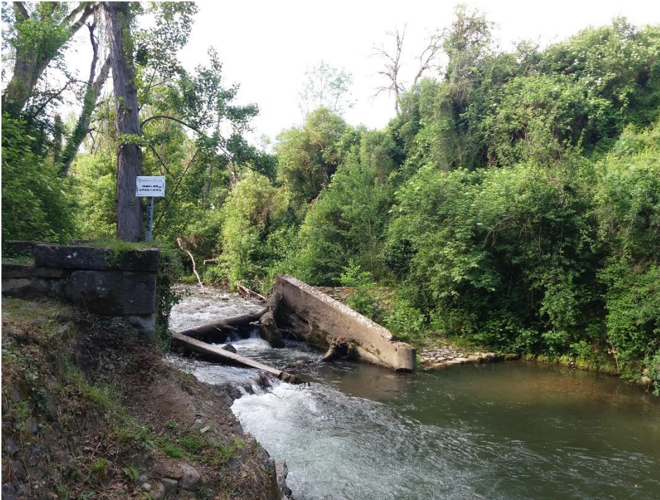
Azud del Remigio en Potes, en el río Quiviesa (antes de la actuación)
