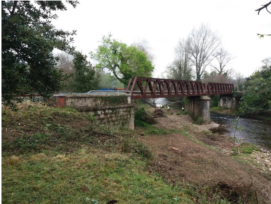
Recuperación de la sección del río y mejora de la capacidad de desagüe del río Miera en las proximidades de Agüero
