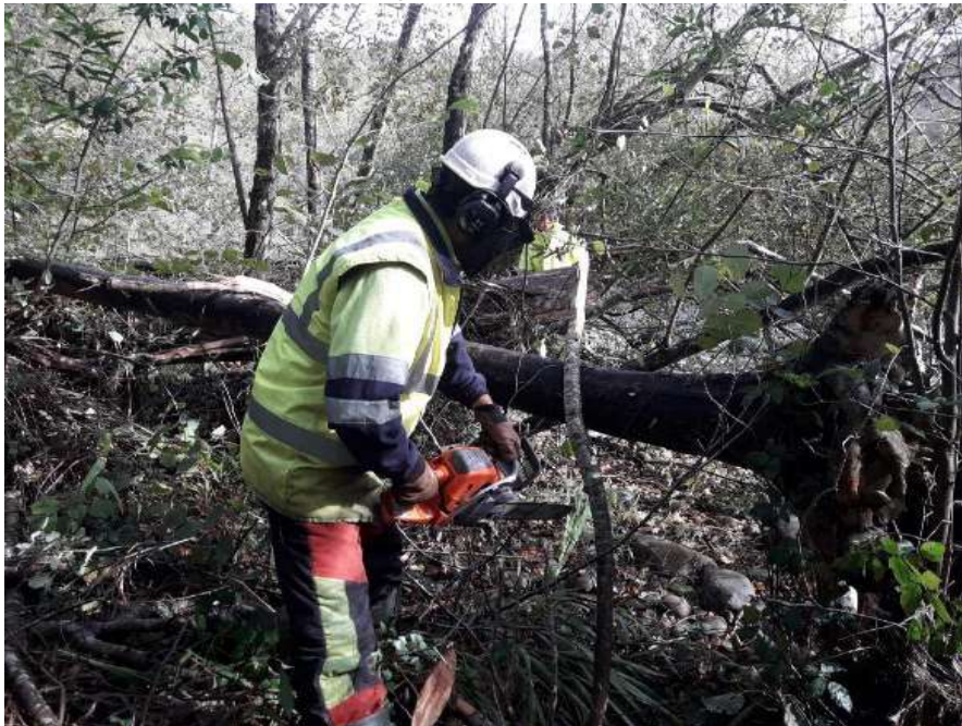
Durante: Trabajos de retirada de vegetación mediante motosierra
