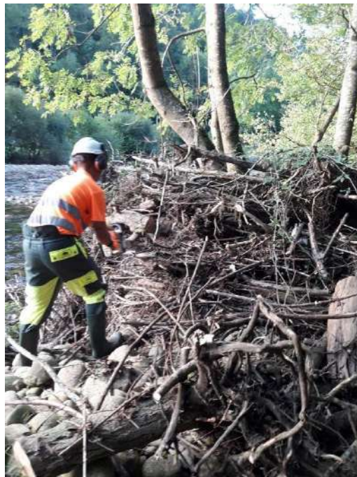
Trabajos manuales de eliminación de restos de vegetación acumulados
