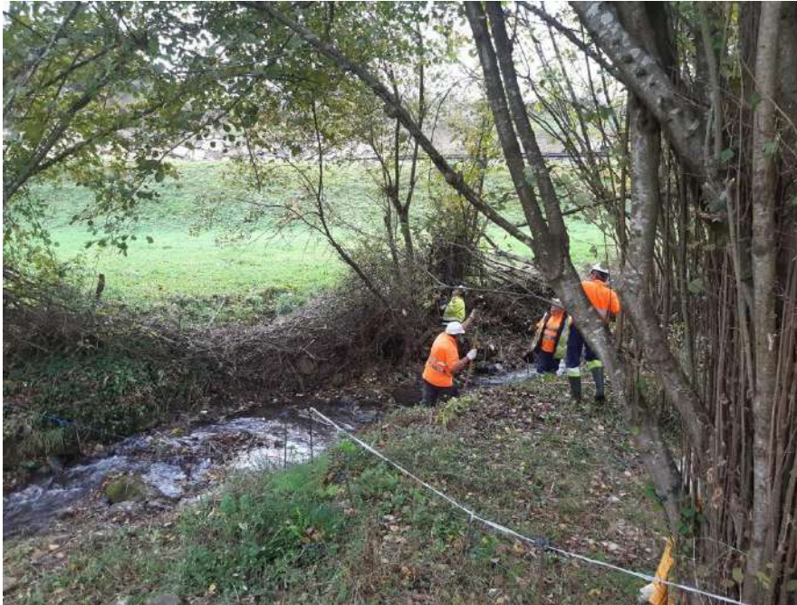
Durante: Retirada manual de restos vegetales
