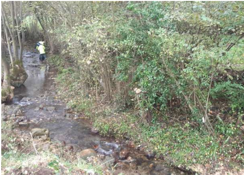
Durante: Trabajos manuales de eliminación de restos de vegetación
