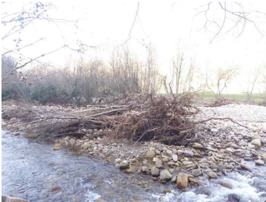
Previo a la actuación: restos vegetales depositados en el lecho del cauce
