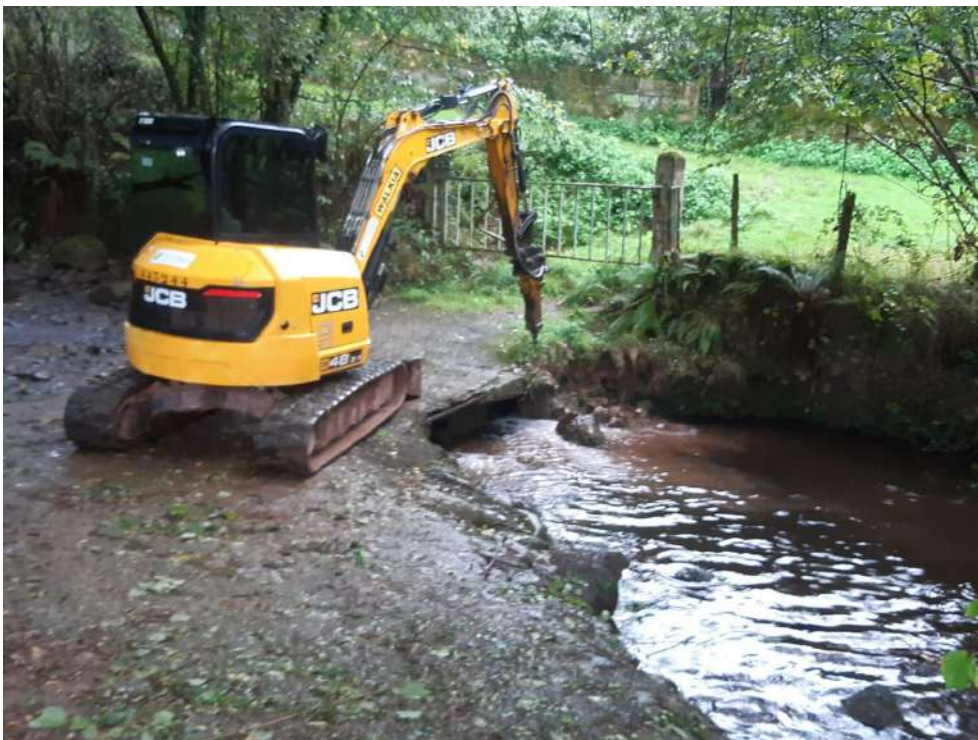
Durante: Trabajos de eliminación mediante picado del vado de hormigón
