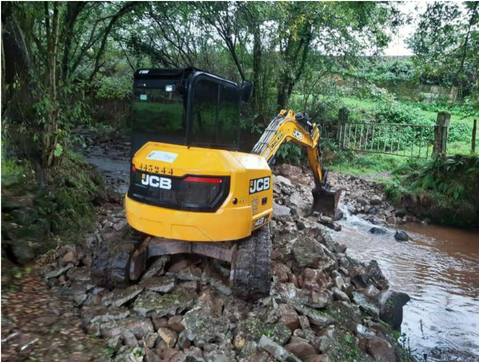
Durante: retirada de los restos de la estructura de hormigón
