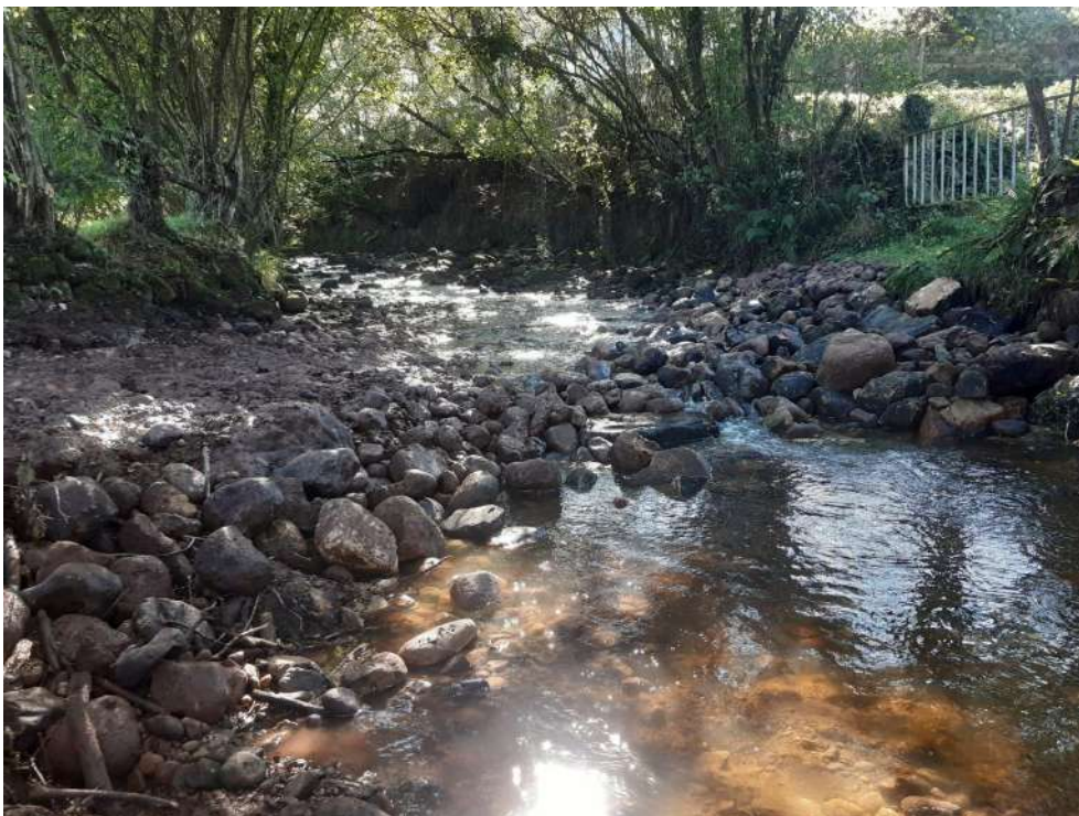
Después: estado del cauce tras la demolición de la estructura de hormigón
