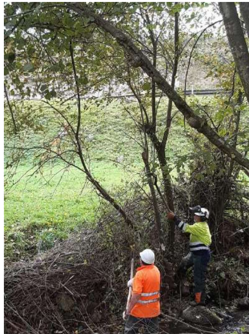
Durante: Trabajos de retirada de vegetación de pequeñas dimensiones con medios manuales
